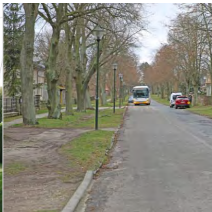
Abb. 14: Wiederherstellung des Radweges auf der südlichen Seite der Dorfstraße Richtung Osten
